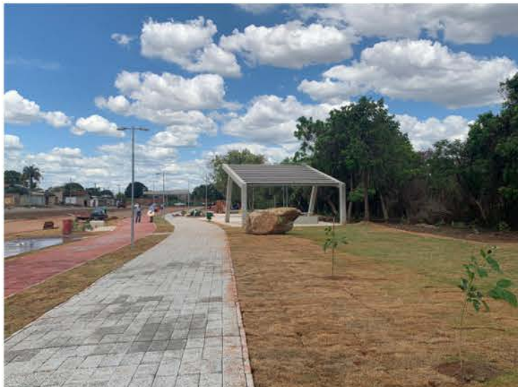
Prefeitura de Goiânia inaugura a primeira etapa do Parque Sebastião Júlio de Aguiar, construído no Setor Parque Oeste Industrial
